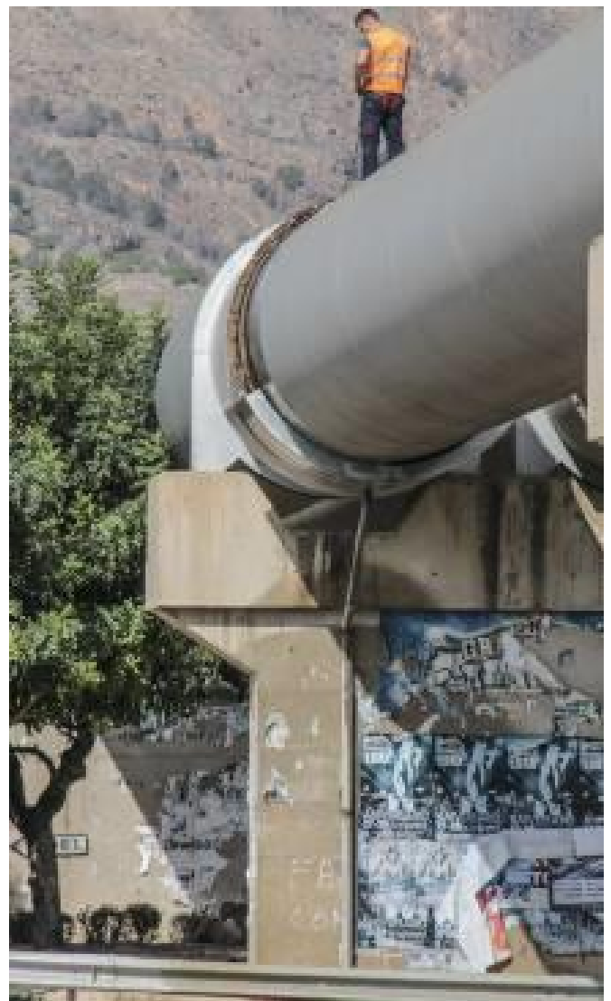
Infraestructura del trasvase.
