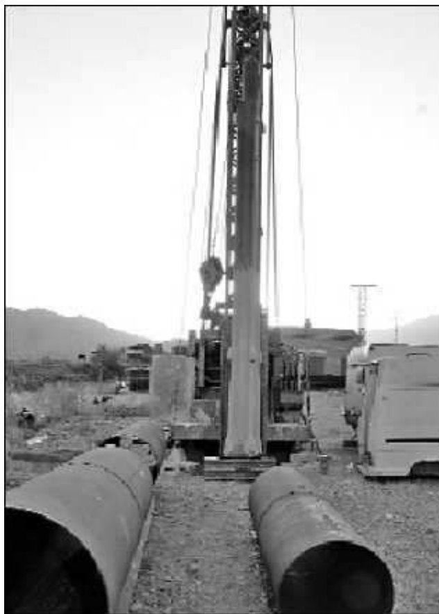
Las obras del nuevo pozo ubicado en el paraje de La Canalosa
