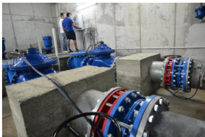
Una de las dos instalaciones creadas en Camp d'Elx para reducir la presión en las tuberías que llevan el agua de riego a los regantes de El Canal. **Matías Segarra**
