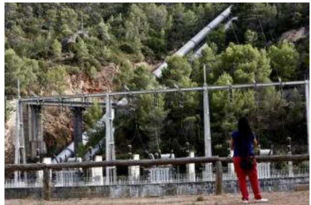
Infraestructura del trasvase Tajo-Segura en el embalse de
