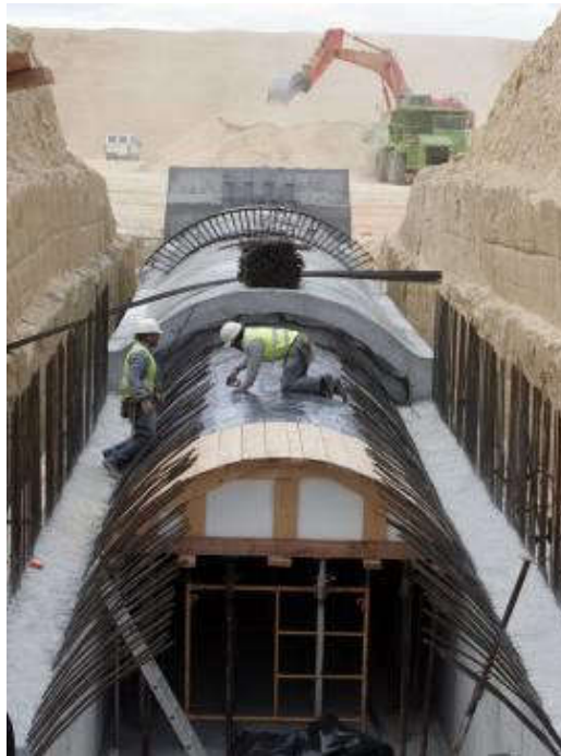
Imagen de archivo de las obras del postrasvase Júcar-Vinalopó.
