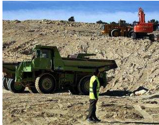
Vista reciente de las obras del postravase que se siguen para construir el embalse en la Cova del Planet DIEGO FOTOGRAFOS
