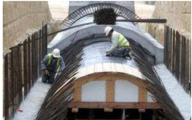
Dos operarios trabajan en las obras del postrasvase. diego foTógrafo
