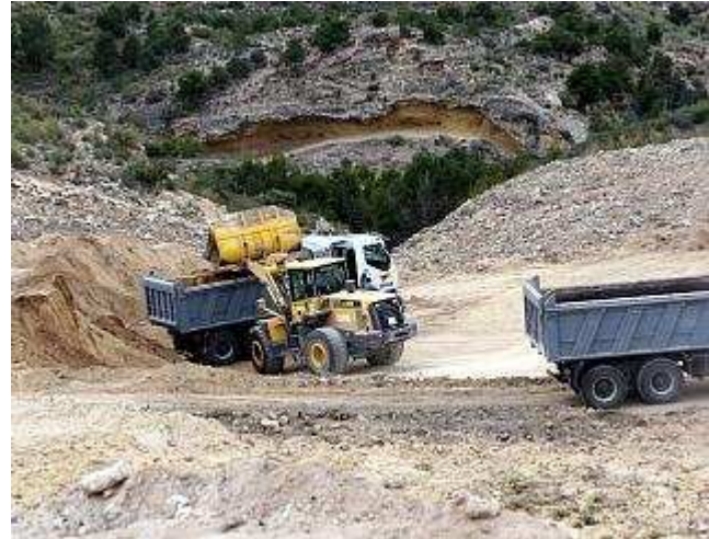
Maquinaria pesada lleva a cabo movimientos de tierra en el inicio de las obras del embalse, en imagen de archivo DIEGO FOTÓGRAFOS
