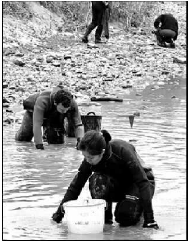
resistente. Limpieza a mano de mejillón cebra en el Canal Imperial javier cebolleda
