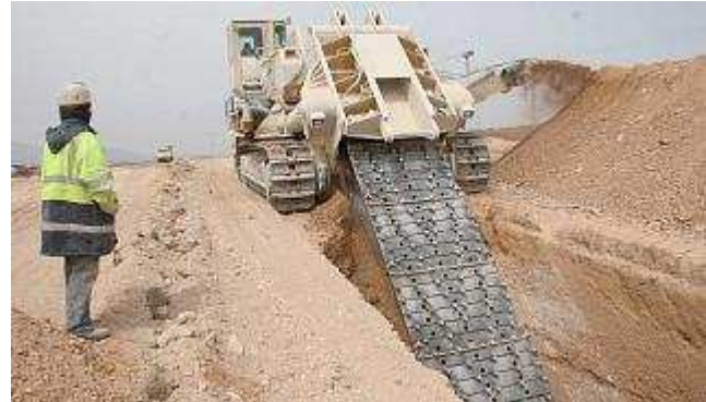
Imagen de la "súper zanjadora" que trabaja actualmente en la segunda fase del postravase en Villena. cruces-ernes
