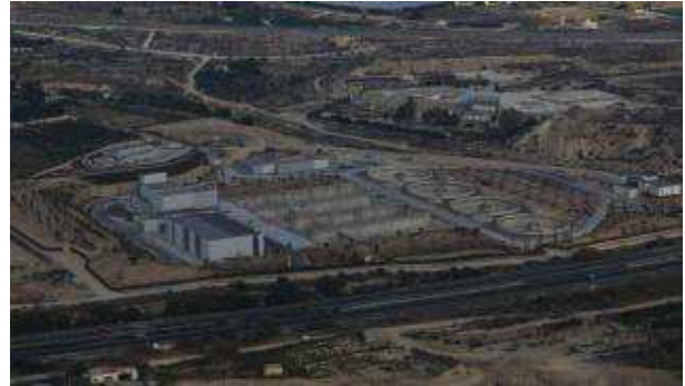
Estación depuradora de aguas residuales de Sant Joan. RAFA ARJONES
