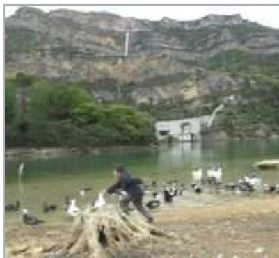
OBRAS. Aspecto de Cortés de Pallas, punto donde inicialmente iba a ubicarse la toma del trasvase del Júcar. / L. GUIL
