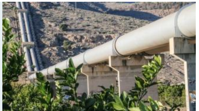
La Confederación Hidrográfica del Segura ya tiene reparado el Canal del Trasvase que se llevó por delante la gota fría de septiembre. TONY SEVILLA
