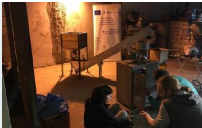
Silo desde que se alimenta la caldera diseñada para poder extraer las cenizas de la paja. consorcio de la ribera
