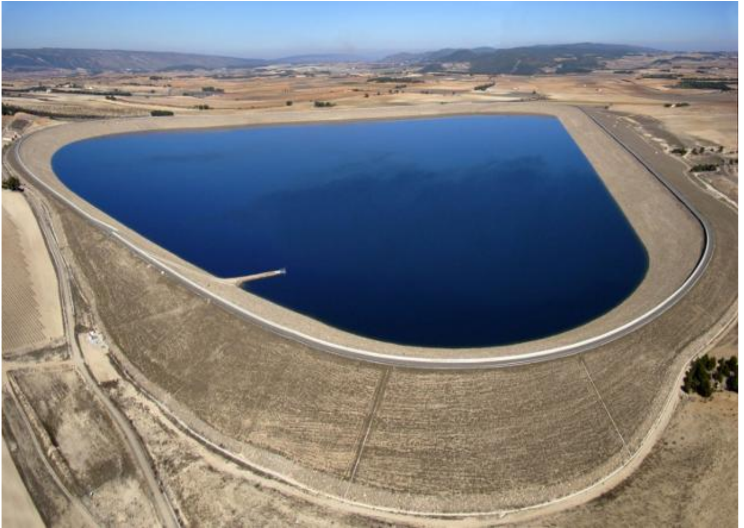
Vista de la balsa de San Diego en Villena. Ip
