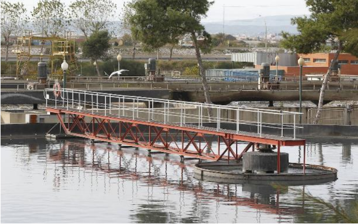
Una parte de la planta depuradora de Pinedo. / JESUS SIGNES
