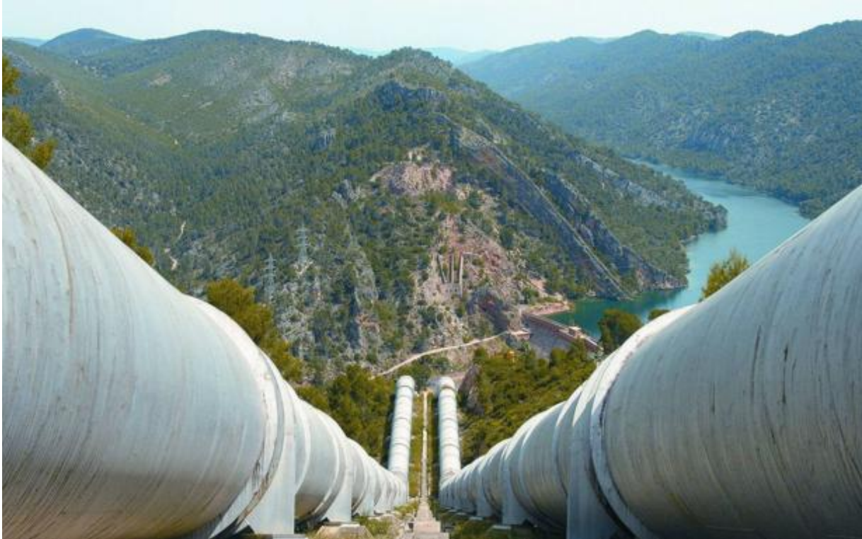
Sistema de impulsión del Trasvase en la cabecera del Tajo. / LV
