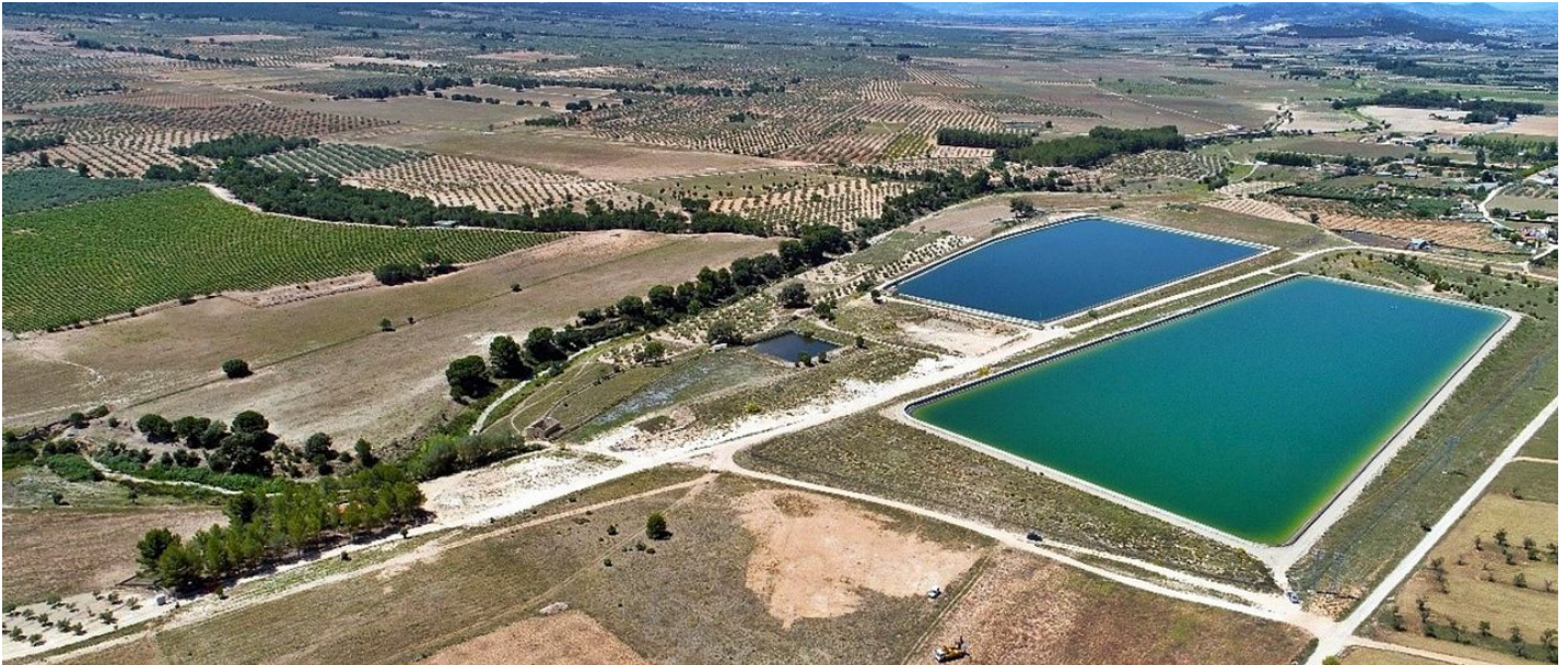
Vista aérea de los dos embalses de la pedanía El Salze, en Beneixama, junto a los que se construirá el nuevo para almacenar las aguas del Vinalopó durante el invierno.
