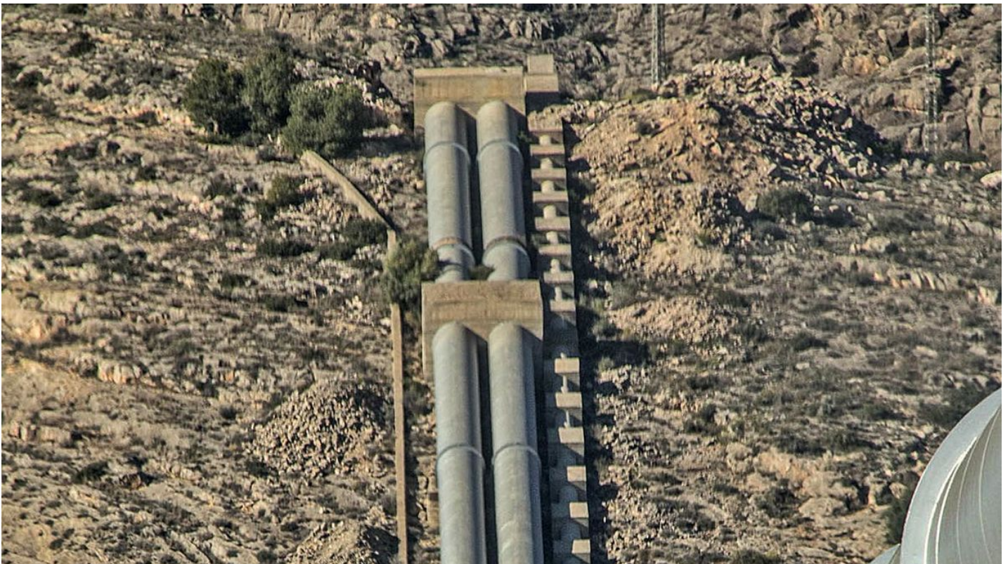
Infraestructura del trasvase Tajo-Segura en la comarca de la Vega Baja. | VICENTE MUÑOZ
