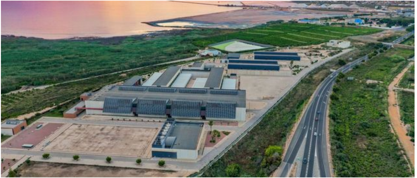
Imagen aérea de la desaladora de Torrevieja, cuya ampliación e interconexión con el resto de las plantas va a tener con coste millonario. | TONY SEVILLA
