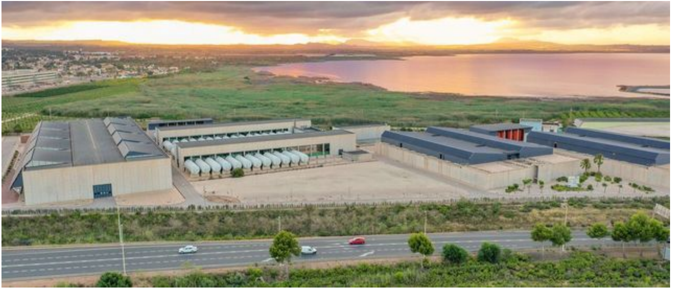
Vista general de la planta desaladora de Torrevieja TONY SEVILLA
