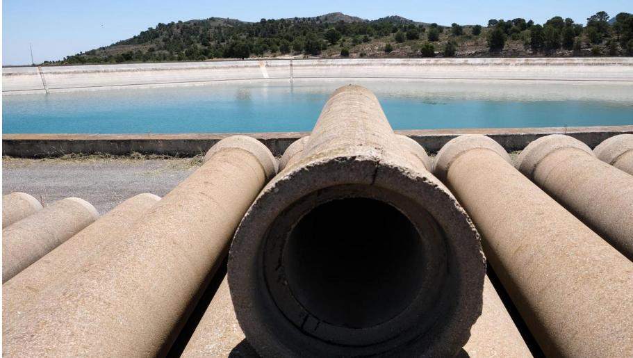
Las obras consisten en la red de tuberías para hacer llegar el agua del trasvase. AXEL ÁLVAREZ
