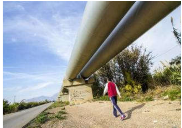
Las tuberías del trasvase Tajo-Segura en Orihuela VICENT MUÑOZ
