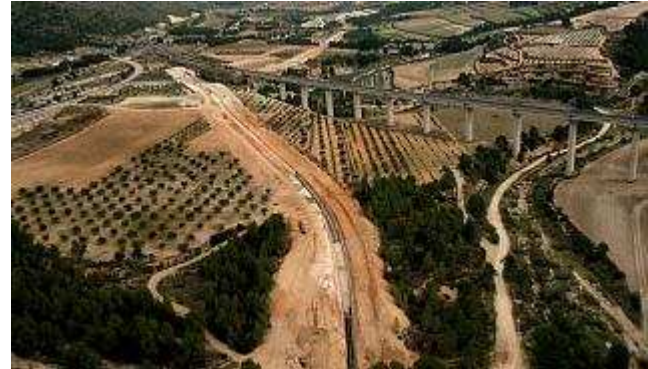
Imagen de archivo de las obras del trasvase Júcar-Vinalopó en el tramo E, a la altura del viaducto de Fuente la Higuera, cerca ya del embalse de San Diego INFORMACION
