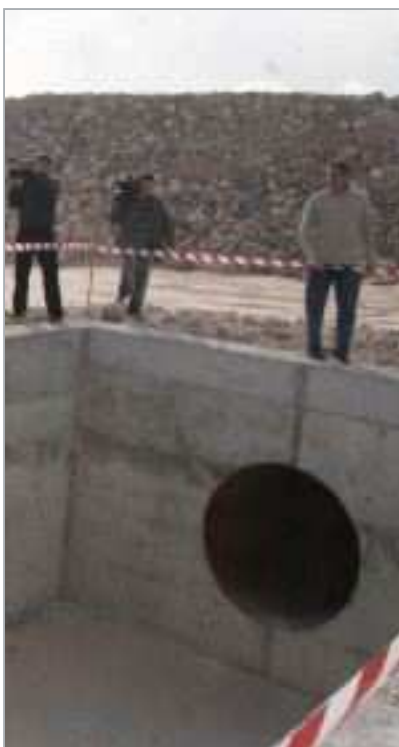
OBRAS. Detalle de la boca del embalse de Villena. / U. ARACIL
