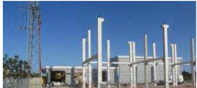
Imagen de las obras de la subestación eléctrica que dotará a la planta desalinizadora. M. Pamie
