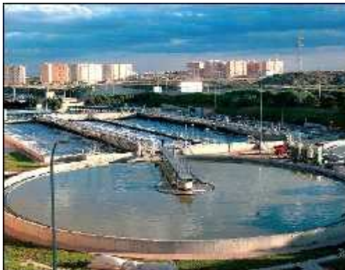
Vista general de la depuradora de Rincón de León, donde se tratan 75.000 metros cúbicos de agua residual al día
