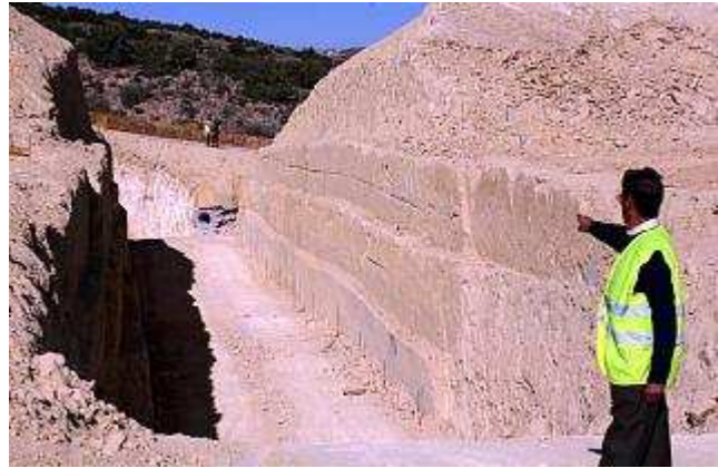
Obras del embalse de la Sociedad Agraria de Transformación San Enrique DIEGO FOTÓGRAFOS
