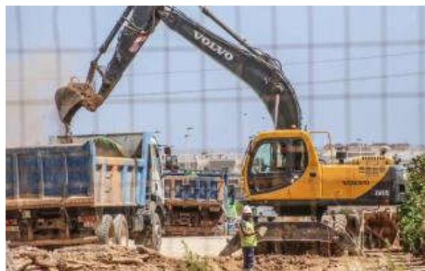
Obras en la subestación eléctrica que da servicio a la desalador
