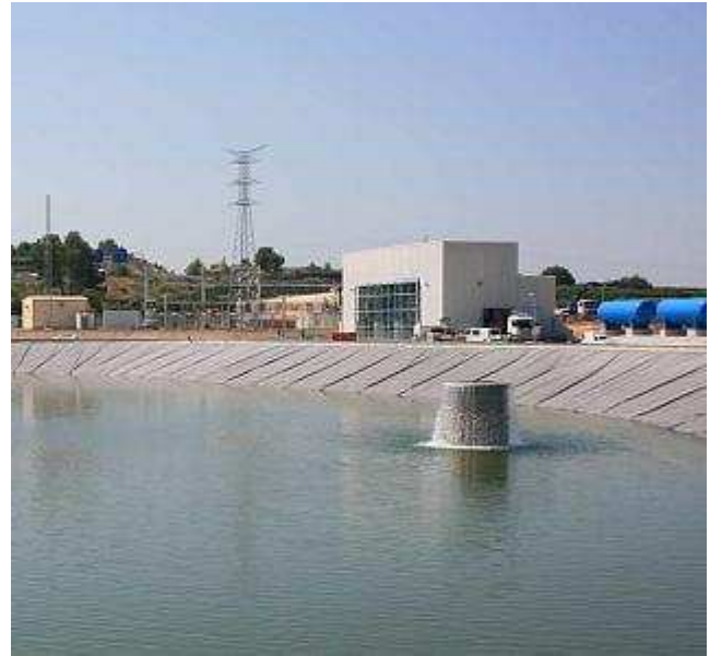
Imagen del bombeo de agua a la balsa de Llanera de Ranes del trasvase del Júcar INFORMACION
