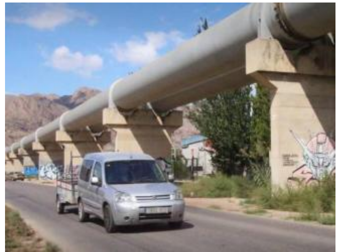
Canalización del trasvase Tajo-Segura a su paso por Orihuela, en
