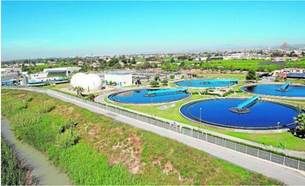
Estación depuradora de la zona este de Murcia, junto al río Segura. JAVIER CARRIÓN / AGM /
