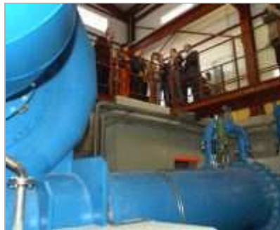
TUBOS. Instalación de la conducción Júcar-Vinalopó en Villena para el postrasvase. / LOLA GUIL
