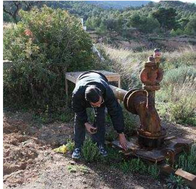
Los ladrones abrieron una gran zanja para extraer todo el cobre de los pozos DIEGO FOTÓGRAFOS
