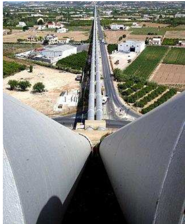
Imagen del canal del trasvase a su paso por Orihuela A. I.
