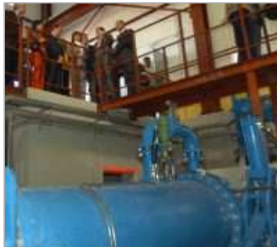
TUBERÍAS. Visita de la ministra Narbona, en noviembre pasado, en el término de Villena. / LOLA GUIL
