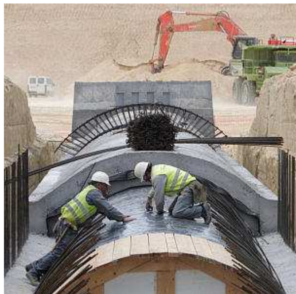
Dos operarios trabajan en uno de los canales que se soterrarán para llevar el agua al Baix Vinalopó
