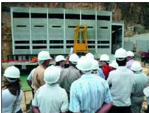
Presidentes de comunidades de regantes del Vinalopó observan la estación de bombeo de Cortes el 8 de julio de 2005
