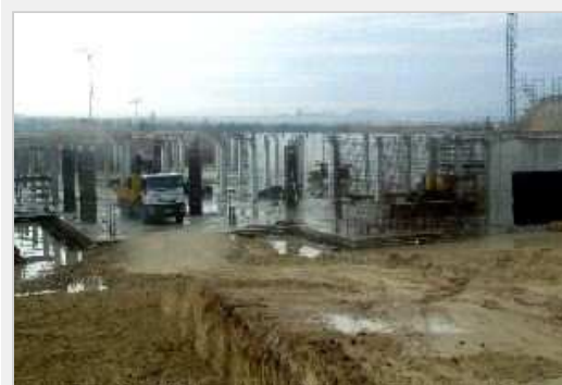
OBRAS. Trabajos en la desalinizadora de Torrevieja, en imagen de archivo. / EFE/MORRELL
