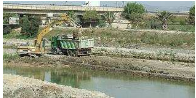
Aspecto del dragado del cauce nuevo del río Segura en la cercanías de la desembocadura en Guardamar, que permite retirar el "tapón" formado por sedimentos. cales:
