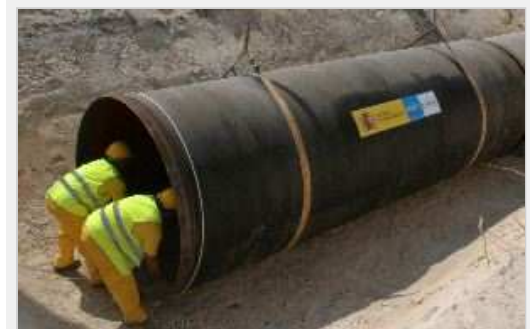
COMIENZOS. Dos trabajadores en el inicio de las obras, el pasado mes de julio. / U. ARACIL
