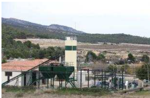
Imagen de la depuradora de Ibi, cuyo caudal sobrante irá a para a los regantes. RUBÉN CERVERA
