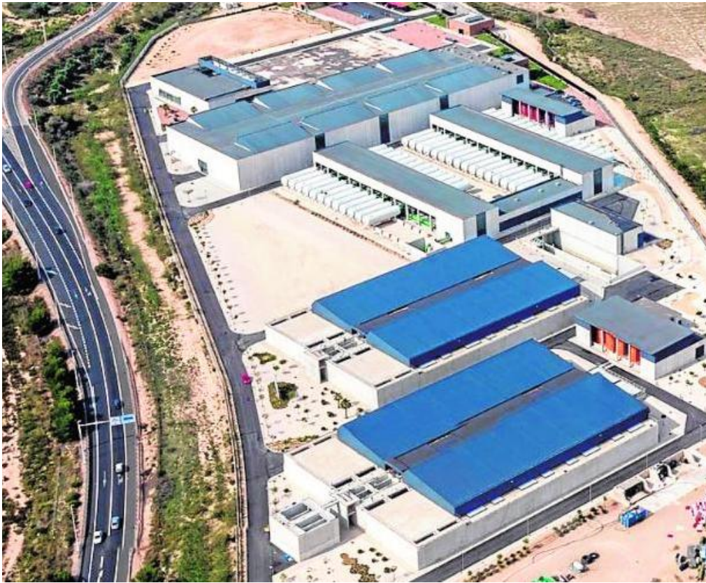
Vista aérea de la desaladora de Torrevieja que gestiona Acuamed. /
