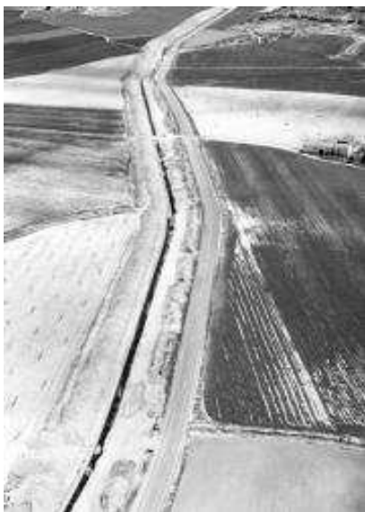
ABC Las obras del nuevo trasvase comenzaron a finales de junio
