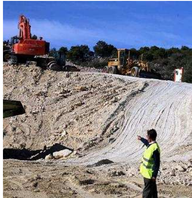
Obras del embalse de San Enrique, desde donde partirá la modernización DIEGO FOTOGRAFOS
