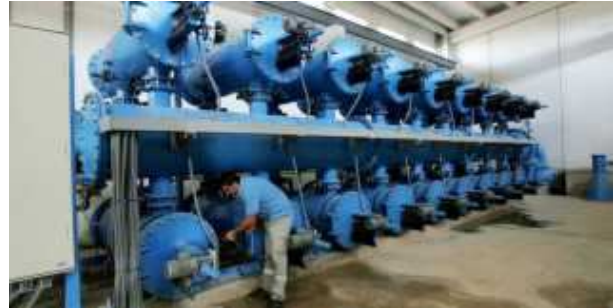
La estación de filtrado de la comunidad Cuarto de Levante y Séptimo de La Peña. DIEGO FOTÓGRAFOS
