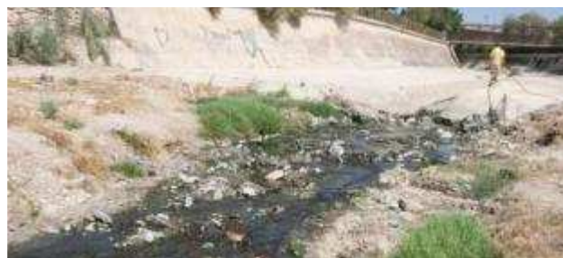
Estado actual que presenta el río Vinalopó a su paso por el casco urbano de Elda. JESÚS CRUCE
