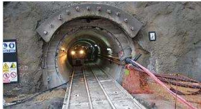
A punto. Uno de los túneles del sifón de Barxeta que pronto quedarán inundados durante la fase de pruebas. acujúcar
