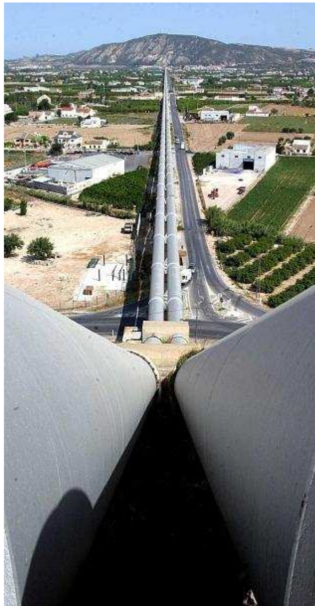
Imagen de la tubería del trasvase Tajo-Segura a su paso por la Vega Baja MORELL
