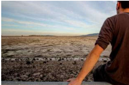
La central hidroeléctrica del trasvase en Villena lleva siete años sin uso al cambiar de conexión el Consell
